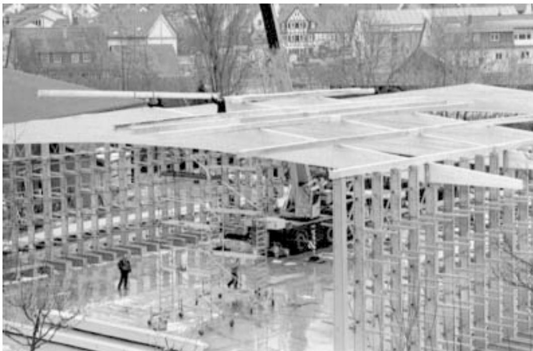
Die Lagerhalle im Bau
