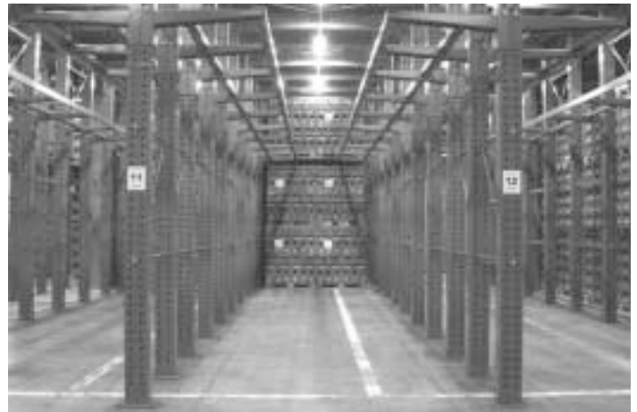
Einlagerungskanal für Doppelpaletten
