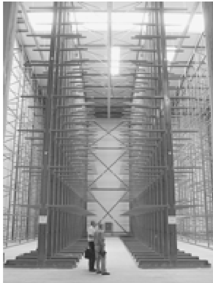
Innenansicht des Lagerteils mit Freitrageregalen
