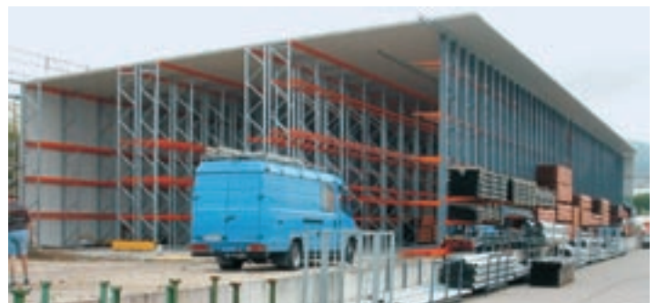
Image 3: Hall autoportant reposant sur des palettiers et cantilever ELVEDI. Les rayonnages portent les parois et le toit.
