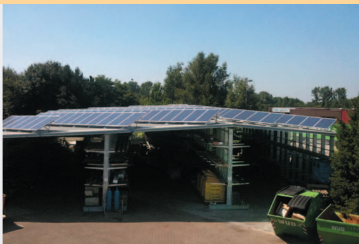
Dachtragende Palettenregale bei Krein
