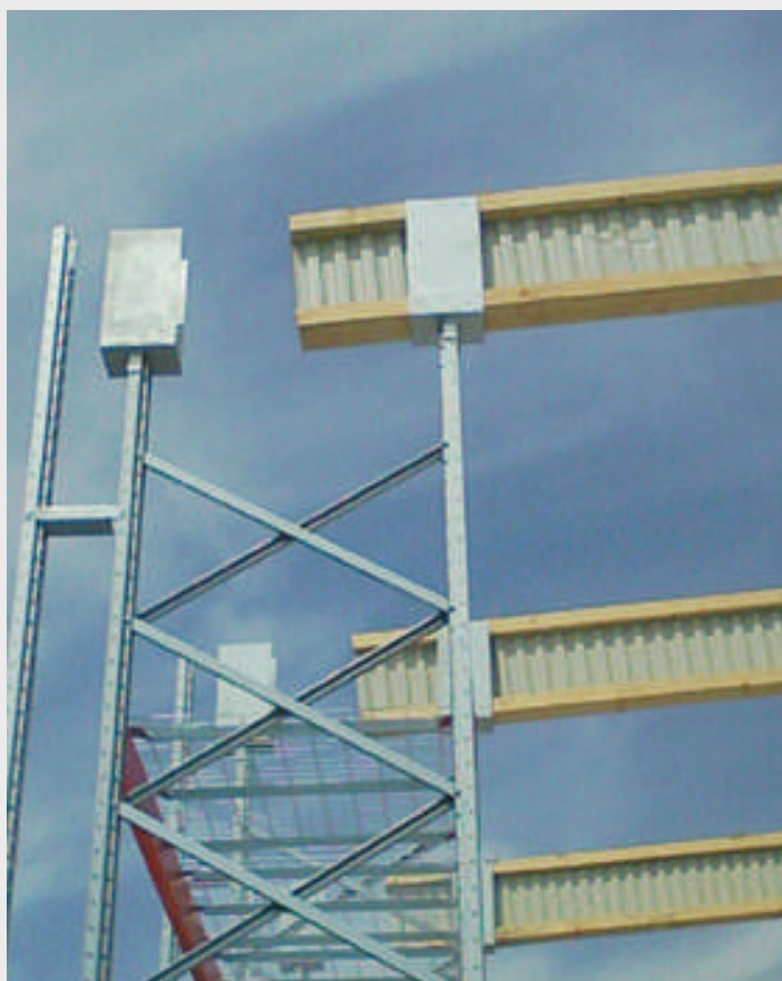
Spezielle Laschen fixieren die Dachstreben an den Palettenregalen
