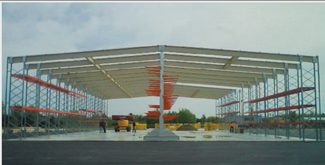
Die ELVEDI-Regale tragen Dach und Wände der neuen Lagerhalle
