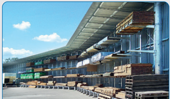
Rayonnage Cantilever comme entrepôt de bois et matériaux de construction avec couverture et bardage
