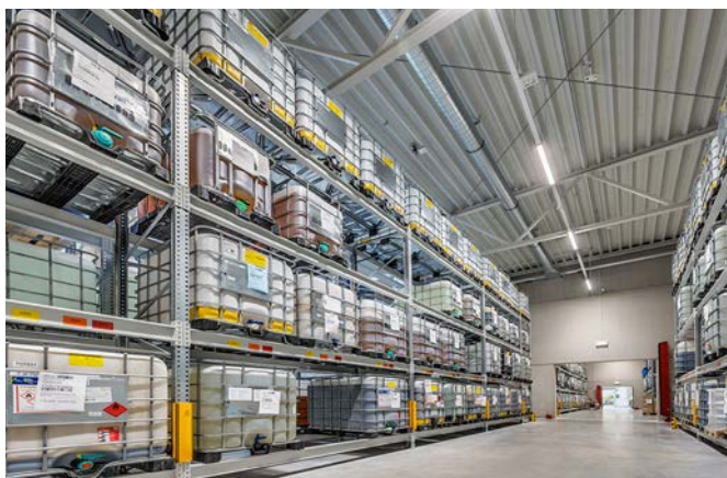
Dans l'entrepôt de marchandises dangereuses, les rayonnages à palettes PAOM peuvent accueillir 204 conteneurs IBC.
