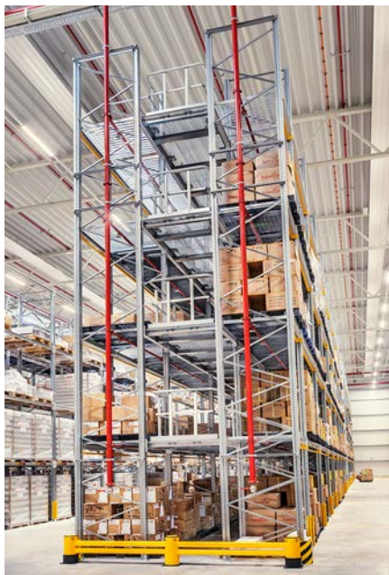
Grâce à un double rayonnage avec couloirs de maintenance intégrés, Wollenhaupt Vanille GmbH peut prélever des échantillons de marchandises sans avoir à sortir des palettes.
