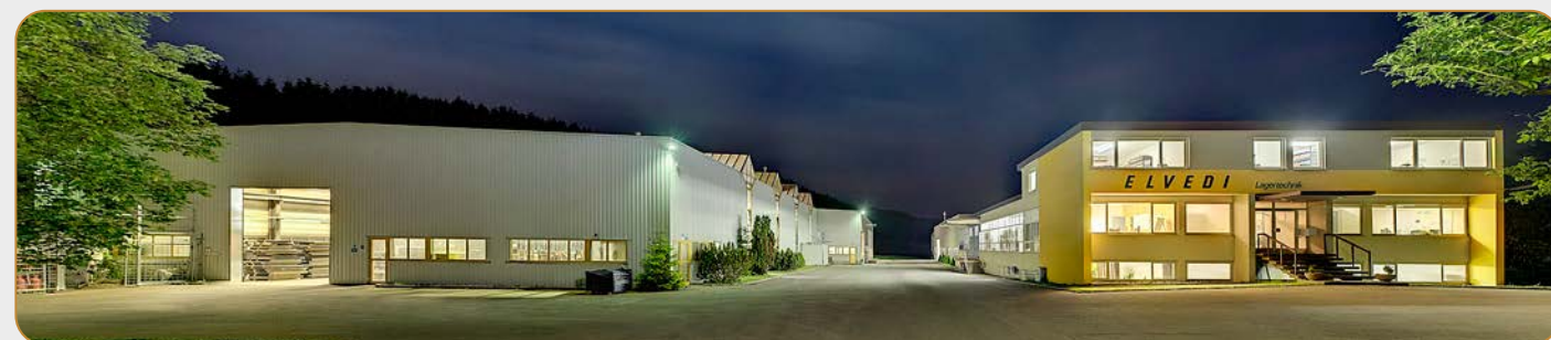
Le site de production de rayonnages cantilevers à Blumberg (Forêt-Noire). Tous les produits sont exclusivement « Made in Germany ».
